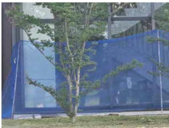
▲ 飛石事故防止の安全対策
